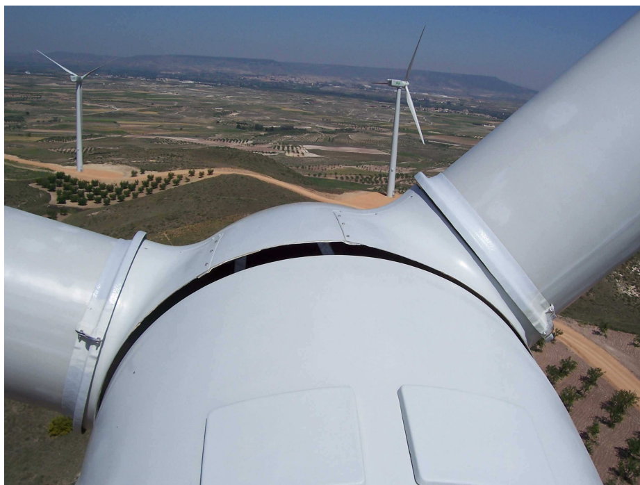
Parque eólico de 44,8 MW (Albarite de San Juan, Zaragoza)
